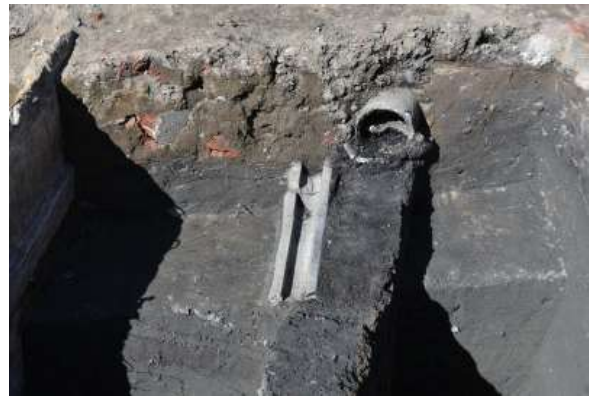
6 第2面 U字溝検出状況（南東から）
